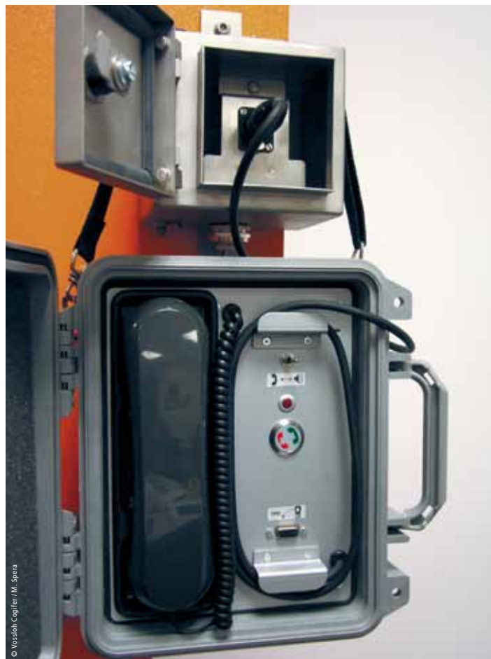
Téléphone de travaux SIEMA à Villeurbanne, France
