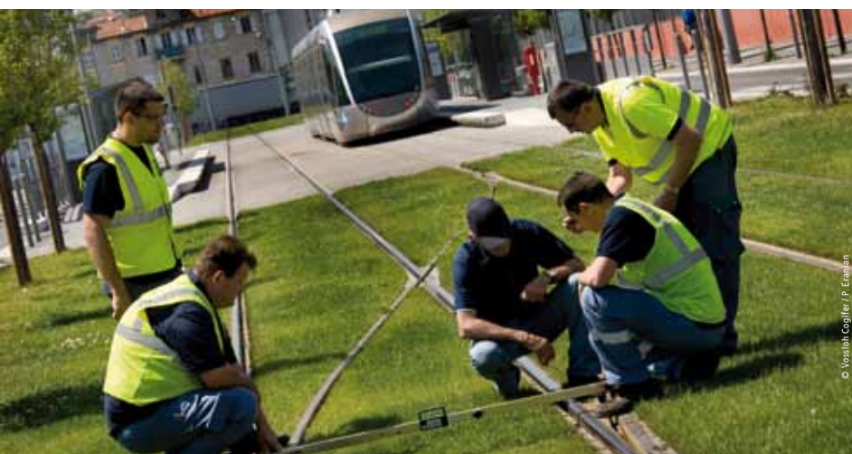
Expertise géométrique d'un appareil de voie, Nice, France
