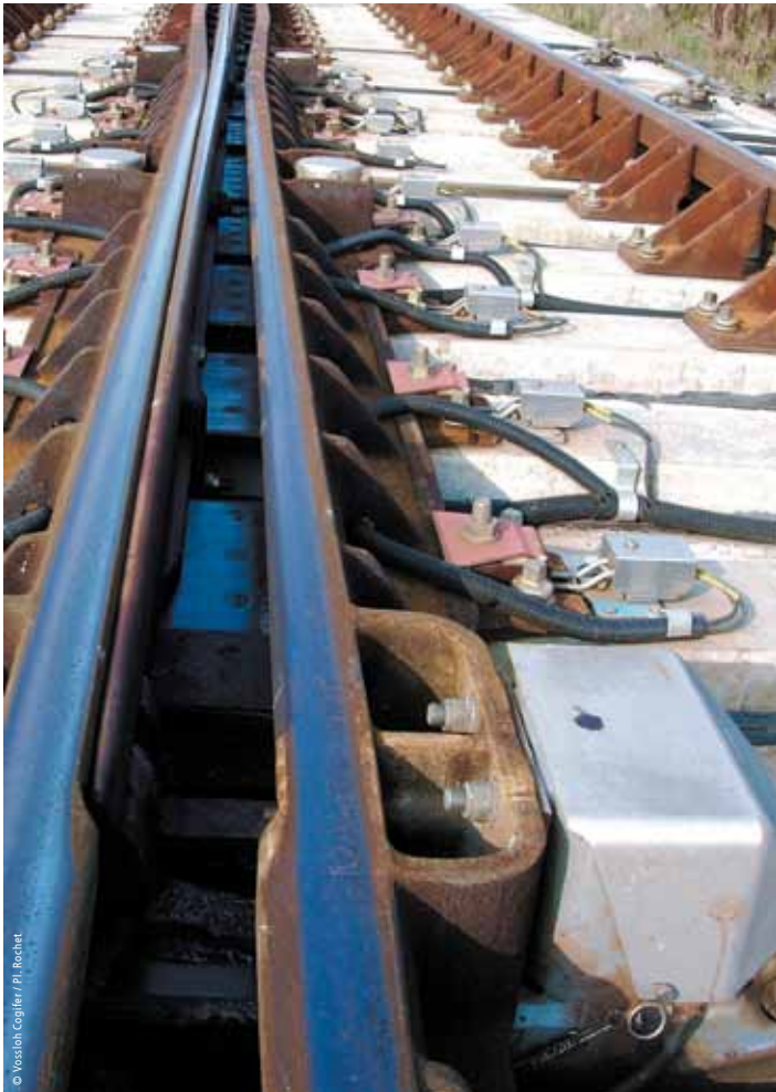
Verrou de Pointe Mobile, ligne à grande vitesse Est-Européenne, France
