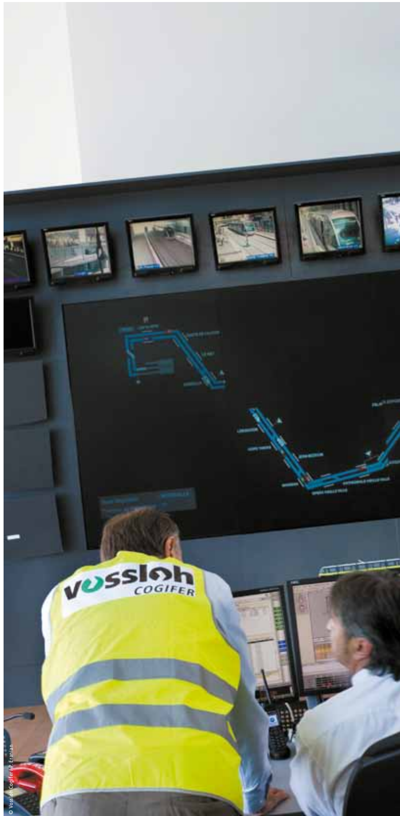
Poste de commande du tramway de Nice, France
