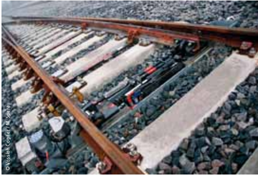
Easyswitch-R (ouvert à gauche, fermé à droite), ligne du tramway de Lyon, station Meyzieu, France
